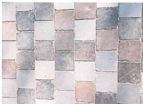
KLOJIMO RAŠTAS TAKUOSE spalvoto klinkerio trinkelės 150x150x65 mm
