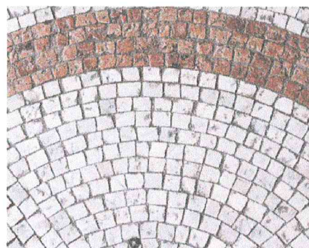
KLOJIMO RAŠTAS AIKŠTĖJE spalvoto klinkerio trinkelės 150x150x65 mm
